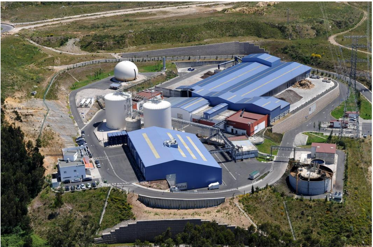
Figura 4 - Vista aerea dell'impianto di trattamento RSU di Almasora-Lisbona, Portogallo (credits Valorsul SA).
